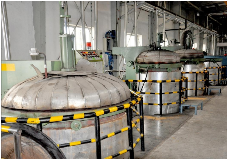
Процесс вулканизации в котле
